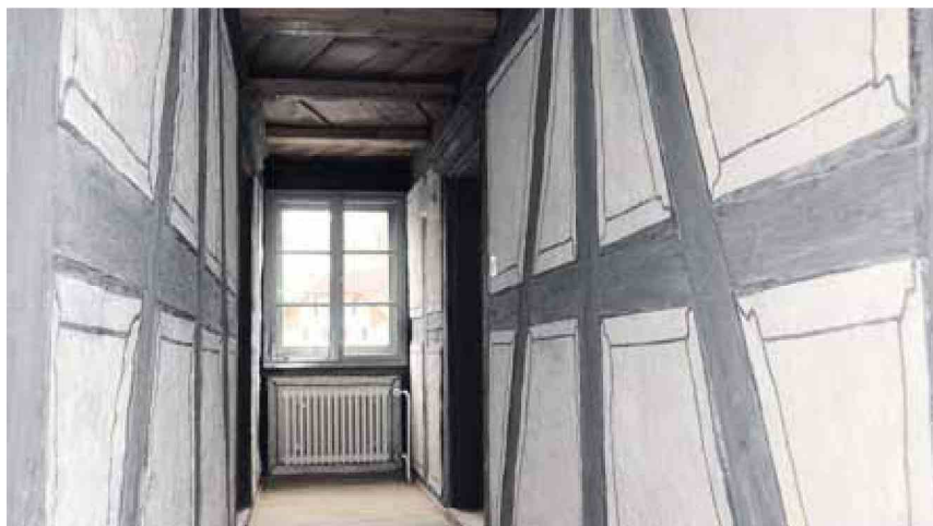
Im Gang im zweiten Geschoss wurde das Fachwerk samt den wenigen Verzierungen im originalen Zustand erhalten.
