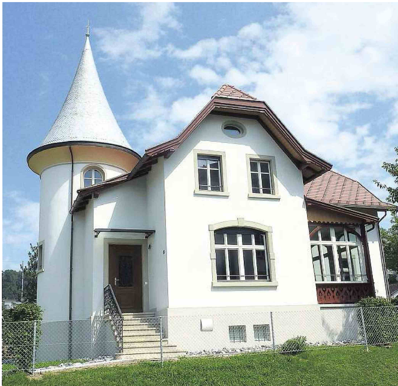
Das «Schlössli» an der Schulhausstrasse 4 erstrahlt im neuen Kleid. Bald kehrt Leben ins Haus zurück. Bild: zvg
