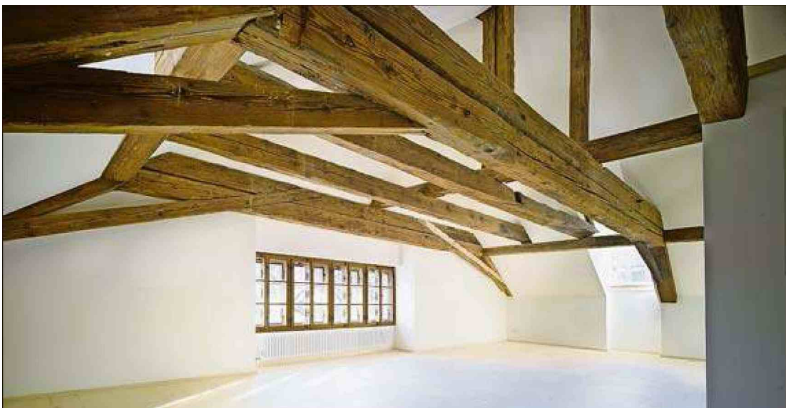
Der Aufwand hat sich gelohnt: Hier die Dachwohnung nach der Sanierung.
