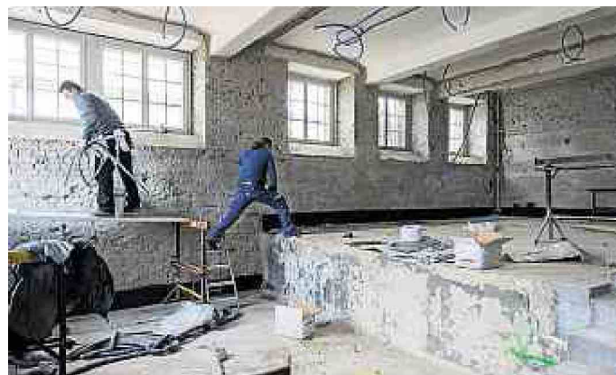
Das neue Lehrerzimmer befindet sich im einstigen Keller.
