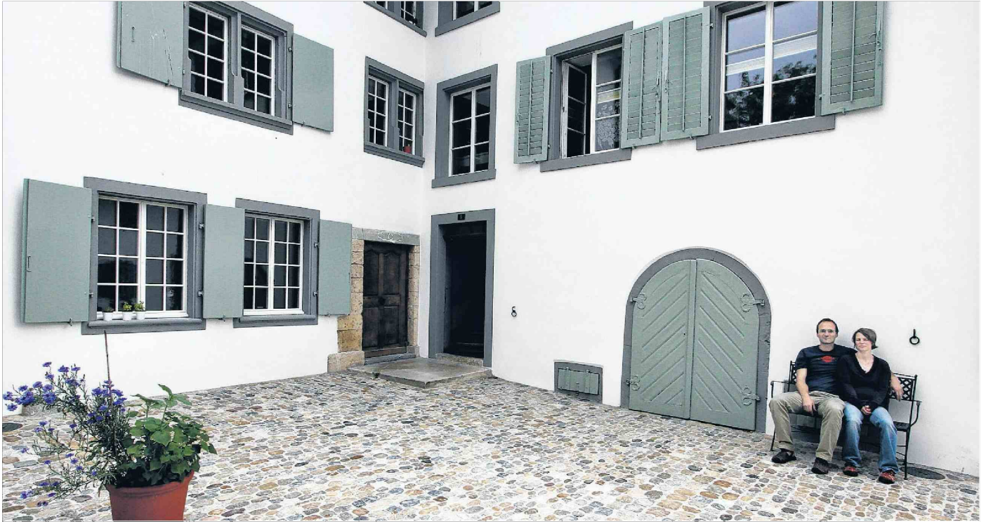
Emil und Esther Franov haben die alte Mühle vorbildlich renoviert.
