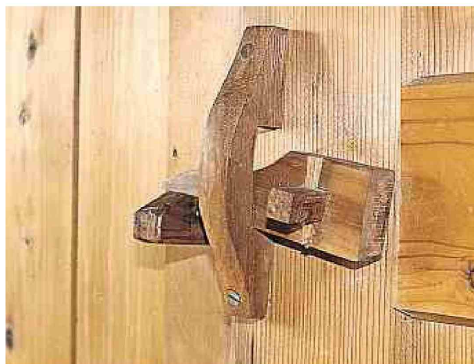
An den alten Holztüren wurde nicht viel geändert, selbst die alten Holzschlösser sind erhalten geblieben.
