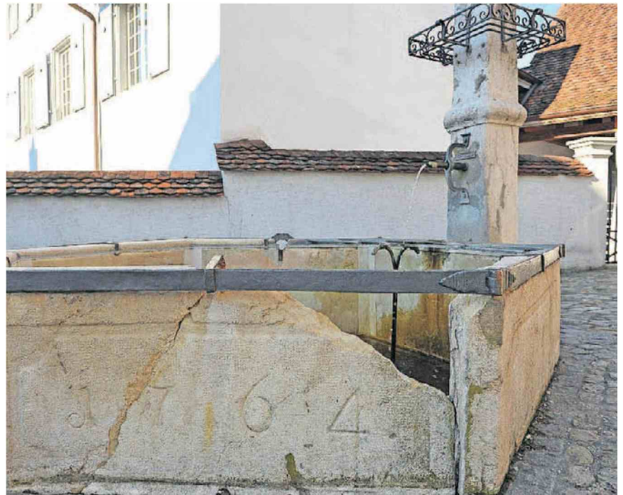
Ein Auto beschädigte den sanierungsbedürftigen Herrenbrunnen.
