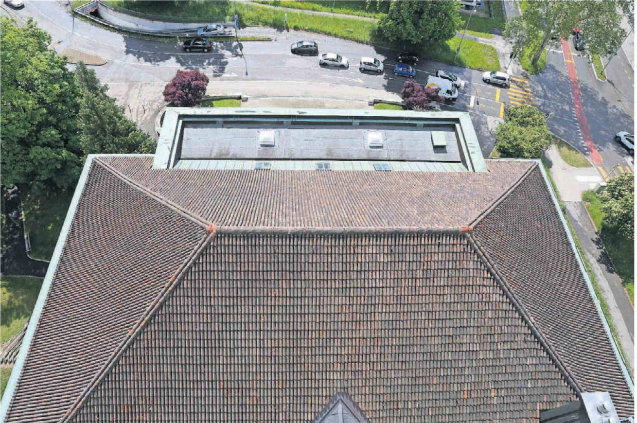
Viel Arbeit steht an – auf dem 762 Quadratmeter grossen Walmdach der reformierten Stadtkirche
