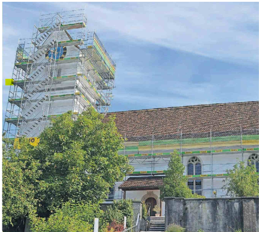
Nächste Woche beginnt die dringend notwendige Renovation.
