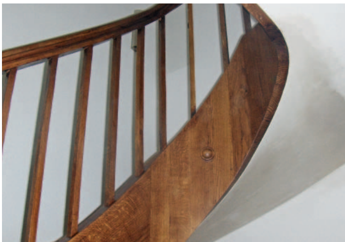
Die neue Wange mit farblich angepasster Oberfläche und ebenfalls neuer Gipsuntersicht.
