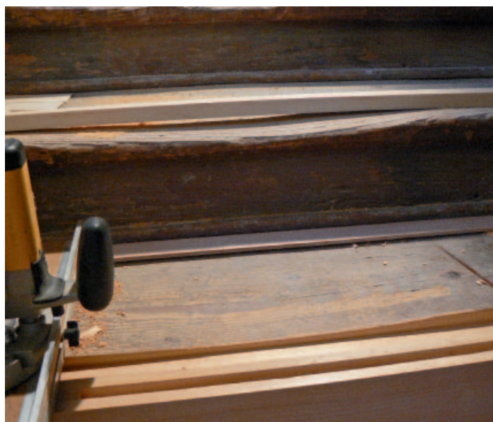
Mittels Oberfräse und Schablone fräsen die Schreiner die stark abgelaufenen Stellen aus.
