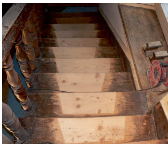
Es wurde aber nur so viel entfernt wie unbedingt nötig. Für das Verputzen kamen nur Handhobel zum Einsatz.
