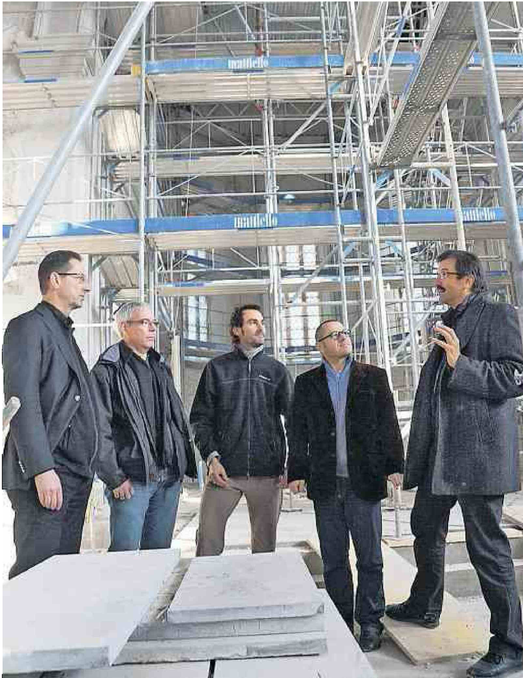
Baustellenbesprechung mit Titus Ladner, Nathan Lutz, Remo Wirth (alle Architekten : rc), Franz Wanner (Sieger des Studienauftrages) und Hansruedi Heeb (Präsident des Kirchenverwaltungsrats, von links).
