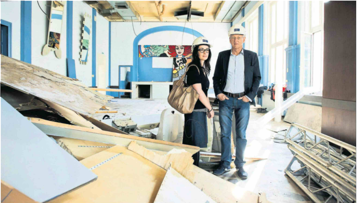
Das Hotel Anker am Pilatusplatz wird komplett umgebaut und erweitert. Peter Eltschinger, Geschäftsführer der Remimag AG, auf einem Baustellenrundgang mit Projektleiterin Sandra Fellmann.
