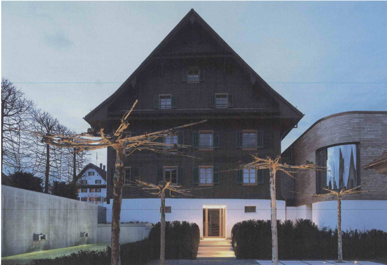
Fast 500 Jahre altes Bauernhaus, wunderbar restauriert und mit neuester Technik ausgerüstet.
