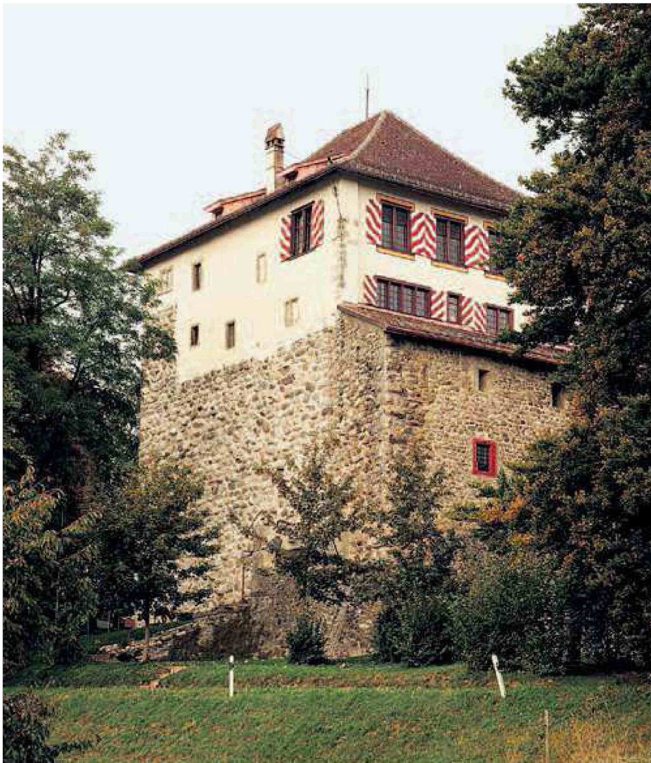
Neue Schindeln unter den Ziegeln, frisches Weiss an den Mauern: Die Mörsburg ist fertig renoviert. Bild: Marc Dahinden
