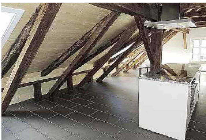
Einblick ins Innere des ehemaligen Bauernhauses mit freigelegter Dachkonstruktion. Rechts ist eine Kochinsel mit Dampfzug erkennbar.
