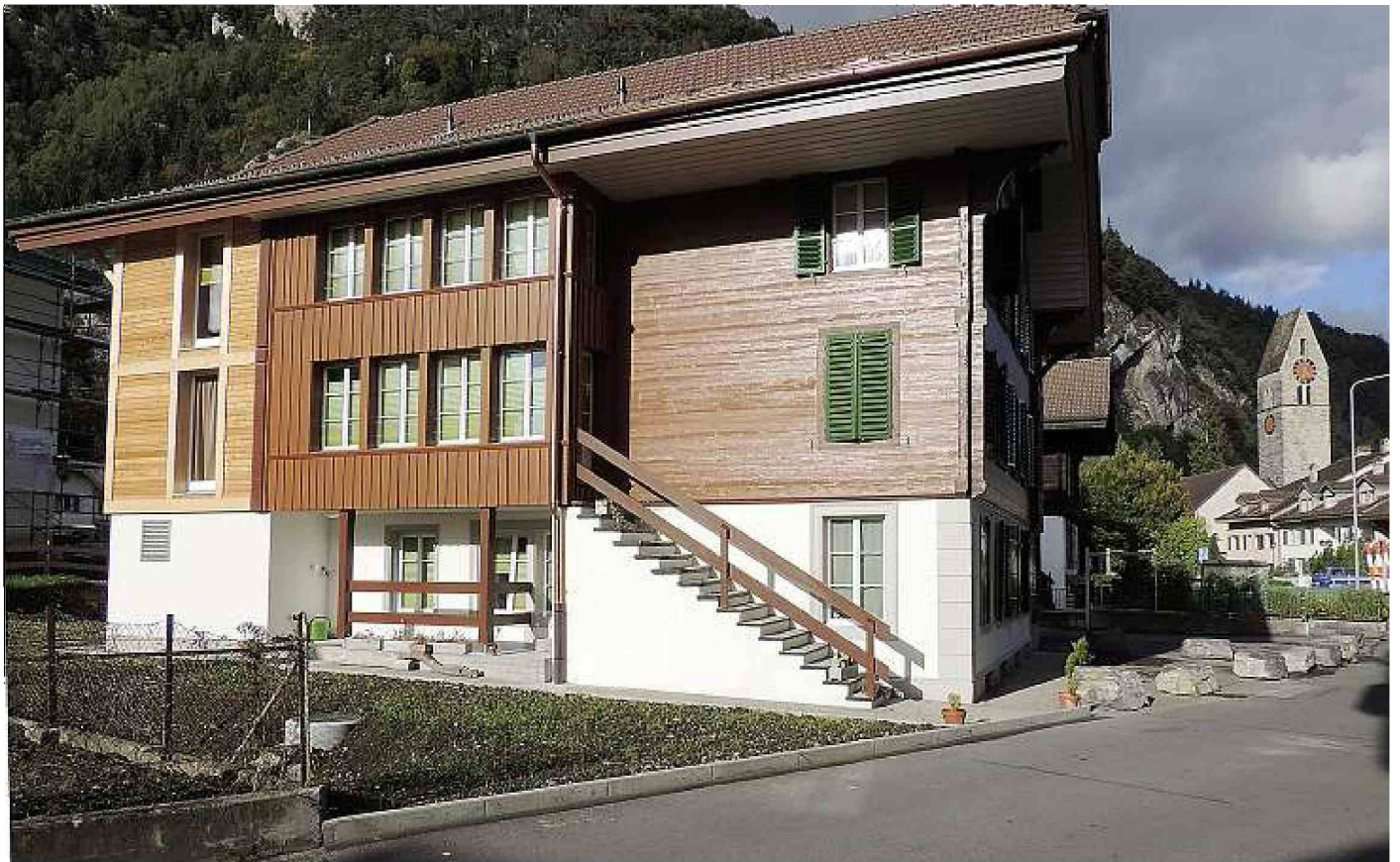
Das ehemalige Bauernhaus an der Freihofstrasse 4 wurde von Grund auf saniert . Rechts im Hintergrund ist der Turm der Kirche zu sehen.
