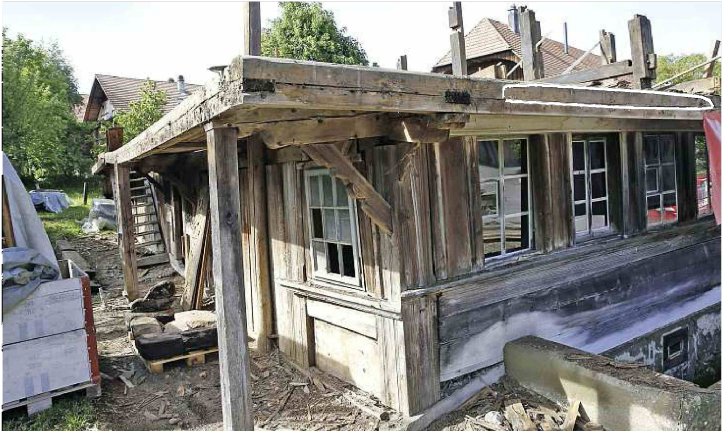
Das Tätschdachhaus wird derzeit Stück um Stück abgebaut. Das Dach ist bereits abmontiert.
