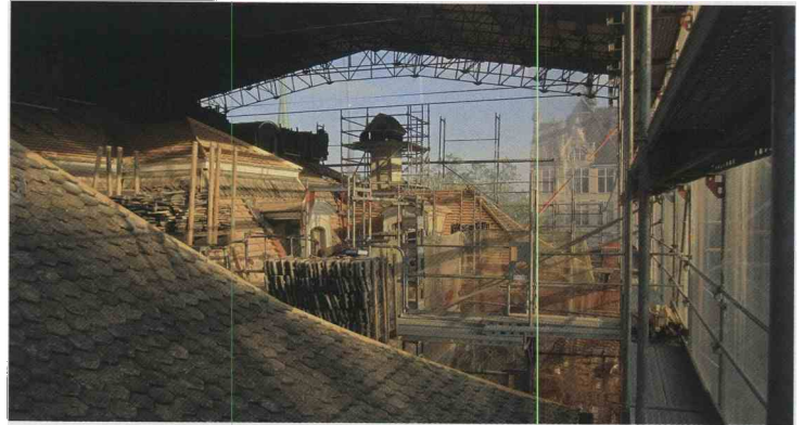
Als das Ziegeldach abgedeckt war, schützte ein provisorisches Dach die historische Bausubstanz und ermöglichte das Arbeiten unabhängig von der Witterung. Foto Scherrer Metec AG
