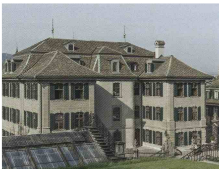
Von der Gartenseite das zentrale Treppenhaus mit den beiden Flügeln. Links das Gewächshaus, nicht im Bild das Pack- und das Waschhaus, die ebenfalls in die Nutzung einbezogen und von Grund auf modernisiert wurden.
