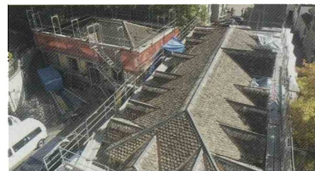
Blick auf die fertig gedeckten Ziegeldächer der beiden Nebengebäude. Foto Scherrer Metec AG
