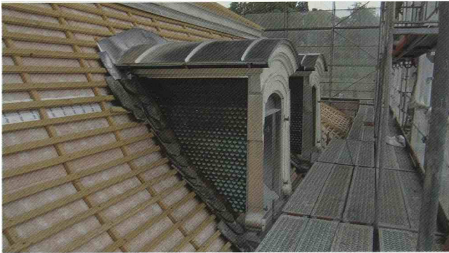
Die Lukarnen sind komplett mit verzinnnten Kupferblechen umkleidet. Das mit Stehfalzen gebaute Dach bleibt blank, die Laibungen sind bereits gestrichen. Die seitlichen Schuppenbleche sind restaurierte Originalbleche. Foto Scherrer Metec AG
