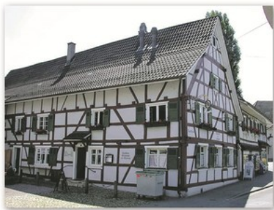
Das schöne Fachwerkhaus erstrahlt von innen in neuem Glanz.
