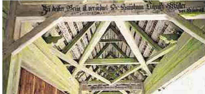
«Zu deifler Brug ist verordnet H. Hauptmann Cunrath Müller von Hundwil» - Inschrift auf einem Spannriegel.
