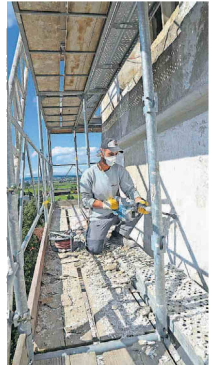
Kuci Valon spitzt in luftiger Höhe den alten Verputz ab.
