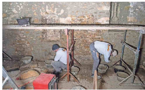
Neuer Putz auf die 2,4 Meter dicken Turmmauern.
