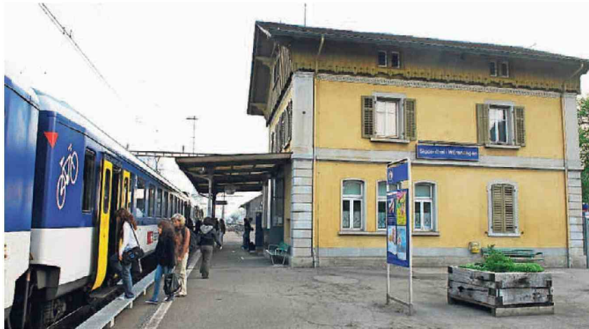
Der Bahnhof Siggenthal-Würenlingen wird renoviert .
