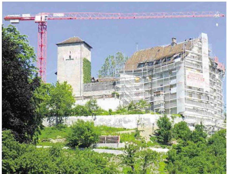
Für die Renovation am Schloss Wildenstein, ist ein breites Fachwissen erforderlich.
