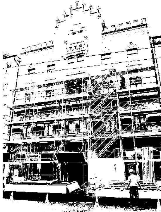
Die verschnörkelte Front des neugotischen «Gloria»-Hauses an der Stadthausstrasse wurde in den letzten Wochen saniert.
