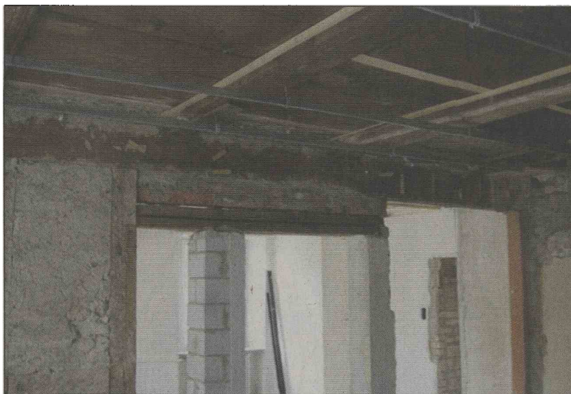
Bauliche Überraschungen im Gemeindehaus Unterkulm: Alte Holztragkonstruktionen wurden mit neuen Stahlträgern abgestützt. (Bilder: zVg.)
