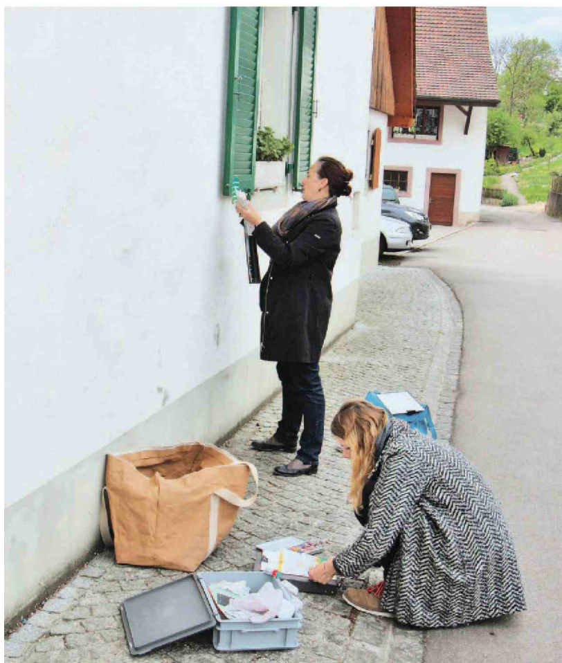
Haus für Haus werden die Fassaden untersucht.
