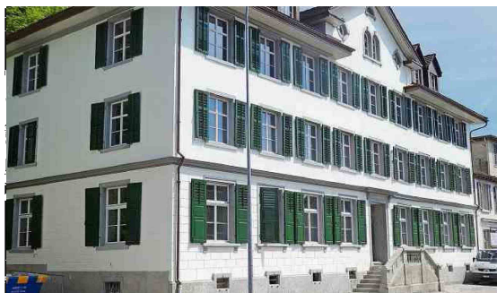
Die Fassade und die Wohnungen des Hauses zum Ruggengatter wurden nach Vorgaben der Denkmalpflege des Kantons Thurgau restauriert.
