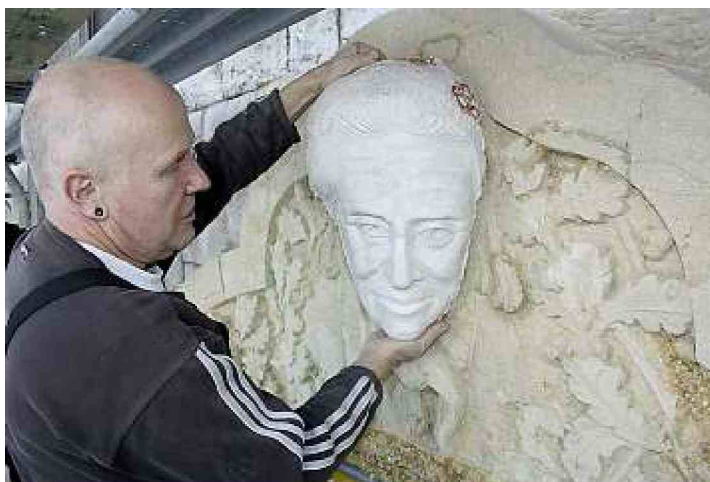
Der Kopf passt: Erich Oetterli überprüft, wie sich der provisorische Gipsabguss ins Bild einfügt.
