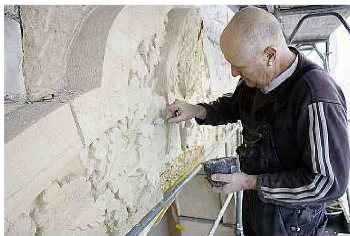
Feinarbeit: Bevor der definitive Kopf eingepasst werden kann, restauriert Erich Oetterli das Blätterwerk drum herum, indem er dieses neu aufmörtelt.
