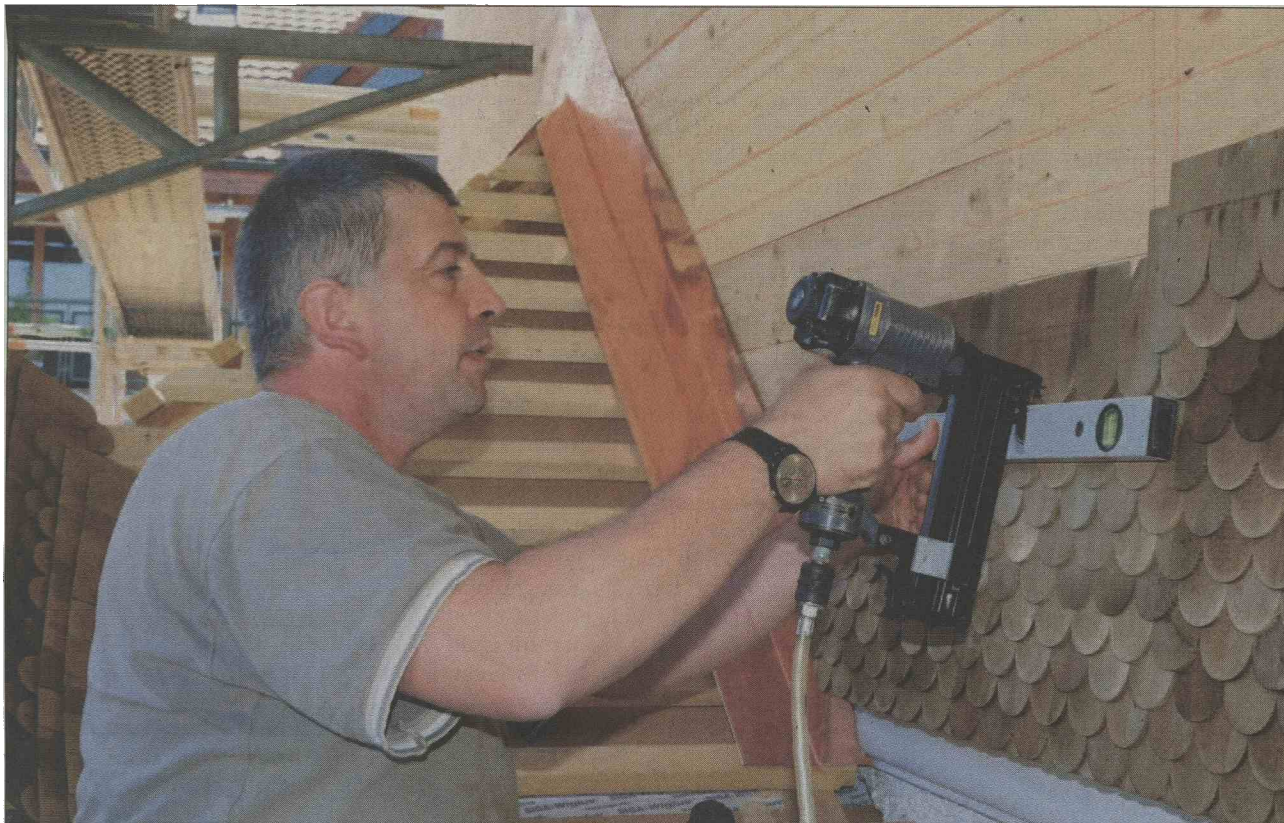
Konzentriert prüft Gerry Stalder die Flucht der Schindeln mit der Wasserwaage.
