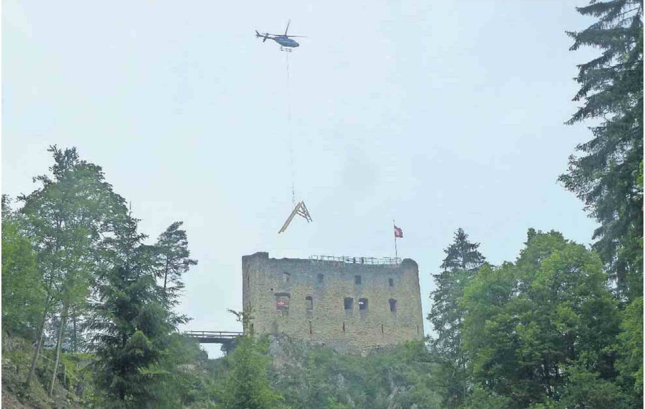
Der Hubschrauber fliegt eine der Holzkonstruktionen zur Ruine Gilgenberg.
