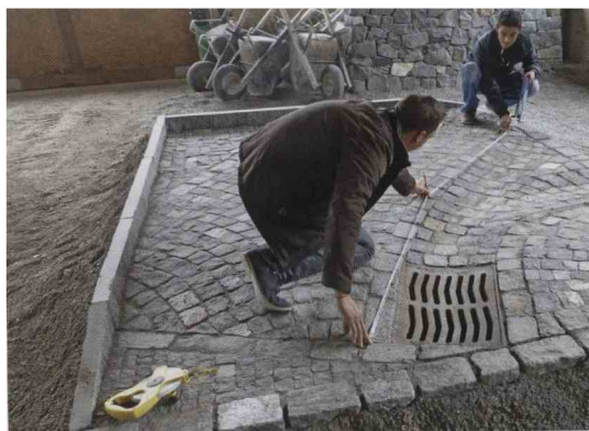
Pflasterer-Vorarbeiter kennen ihr Handwerk von Grund auf.
