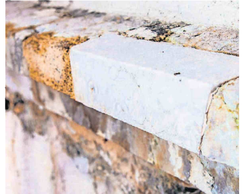
Stark beschädigte Teile des Natursteins werden entfernt und durch neue ersetzt, wie dies bereits bei der letzten Restauration der Fall war.
