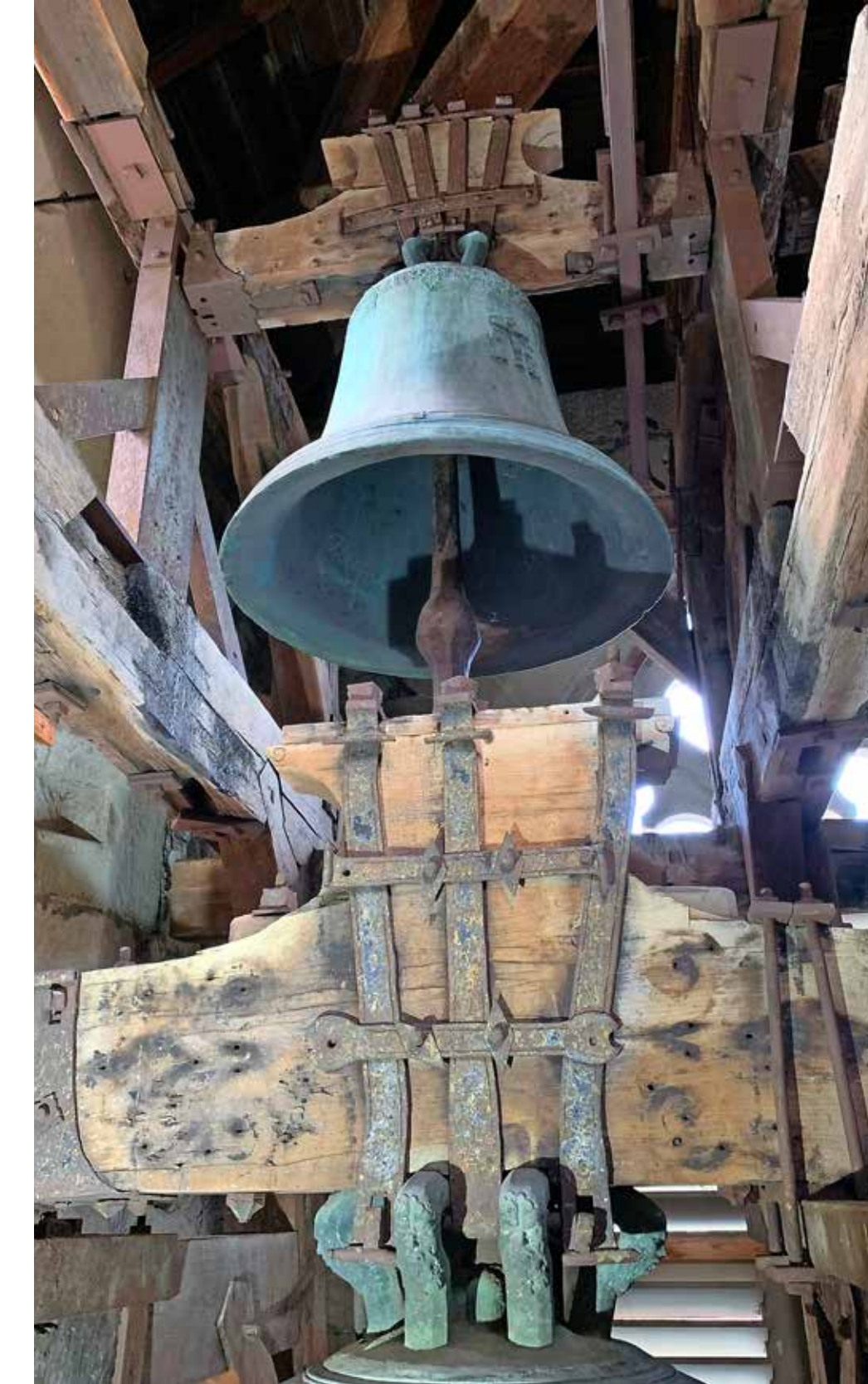
Wenn die Glocken schwingen, verdreifachen sich die Kräfte, die der Glockenstuhl zu tragen hat. Bilder emu
