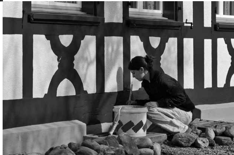
Fachwerksanierung an einem ehemaligen Bauernhaus in Hettlingen. Bild: U. Fritschi
