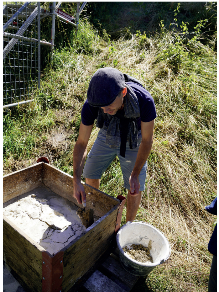
Oben: Patrick Harter berichtet von den Restaurierungsarbeiten an einem Mauerabschnitt, die zurzeit im Gange sind.
