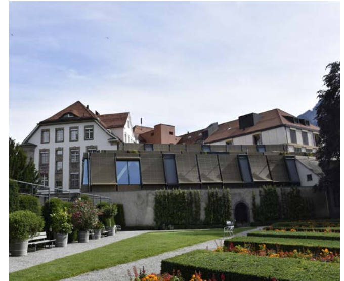
Vom auf der Rückseite der Bank gelegenen Fontana-Park aus nehmen wir den Neubau im früheren Innenhof kurz in Augenschein. Die Stahl-Glas-Konstruktion (in der Bildmitte) will an ein Gewächshaus erinnern.
